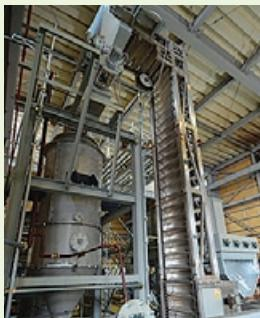
燃料投入システム→ガス化装置
