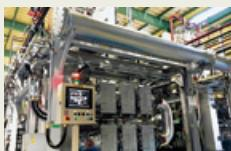
エア・ウォーター株式会社より受注した同施設は、発電設備のみならず、隣接するトマト植物工場での熱利用も可能とした木質バイオマスガス化コージェネレーション装置を導入しています。森林面積が広く、木質バイオマス資源が豊富な地域において、地産地消モデルによる地元産業や地域振興に貢献できるよう取り組んでいます。
