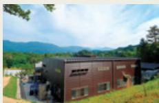
平成27年6月に竣工したこの発電所は、発電時の排熱を間伐材チップの乾燥に利用しており、さらにはいちごハウス栽培にも利用を検討しています。国内初の、固定価格買取制度(FIT)対応型コージェネレーション小型発電システムとして注目を集め、全国の自治体やバイオマス発電をご検討中の事業者様など、1,000名を超える方が見学に来られました。
